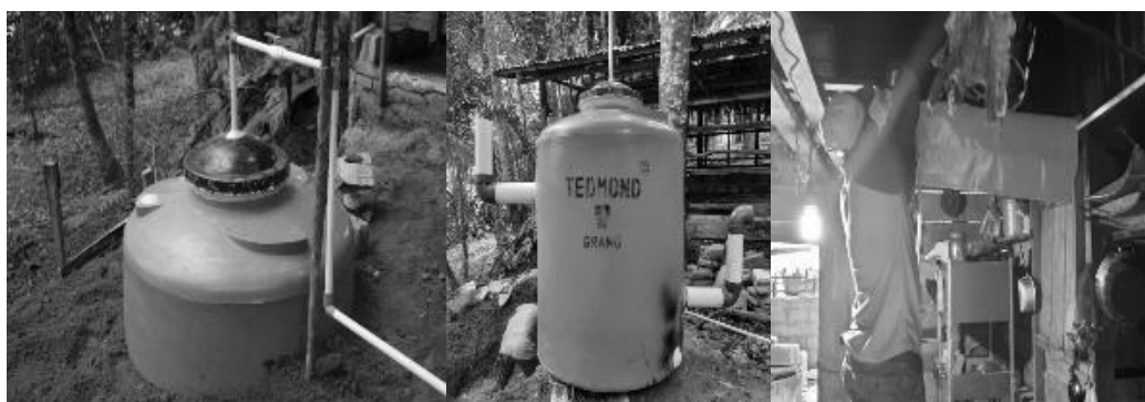
Gambar 3. Pemasangan Instalasi Reaktor Biogas di Desa Koto Simandolak
